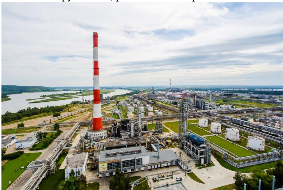
Рис. 64. Ангарский нефтеперерабатывающий завод (НПЗ) (фото с сайта https://rupec.ru/ )
