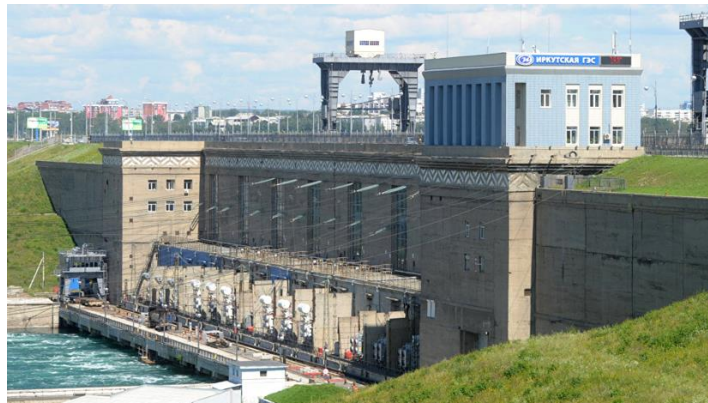
Иркутская ГЭС (фото с сайта https://russian.rt.com/ ) Рис. 59. Гидроэлектростанции Иркутской области
