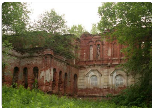
Стены разрушенной Успенской церкви. Фото Н.А. Озеровой. 18.06.2009 г.
